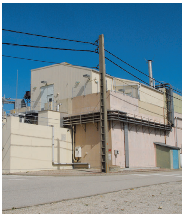
Silo STE2 d'entreposage de boues
