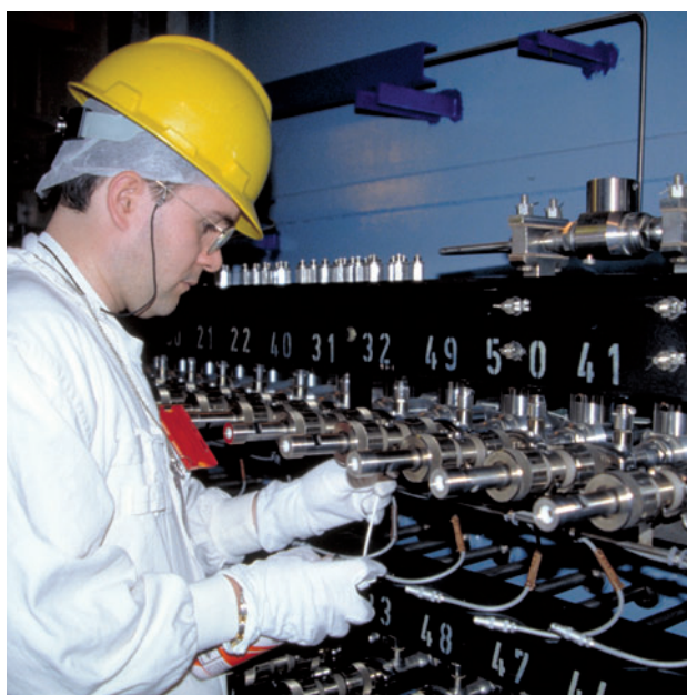
Intervention de maintenance par AREVA sur l'instrumentation du cœur d'une centrale nucléaire
