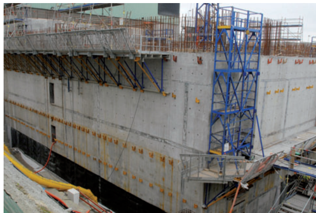
Construction d'une extension du hall d'entreposage des produits de fission (CSD-V)
