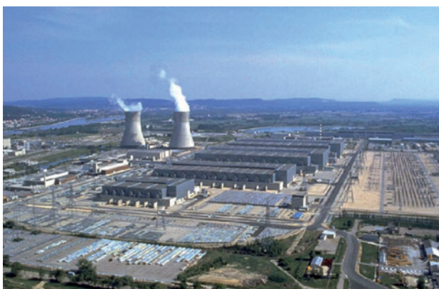
Vue aérienne d'EURODIF, usine de séparation des isotopes de l'uranium par diffusion gazeuse sur le site du Tricastin
