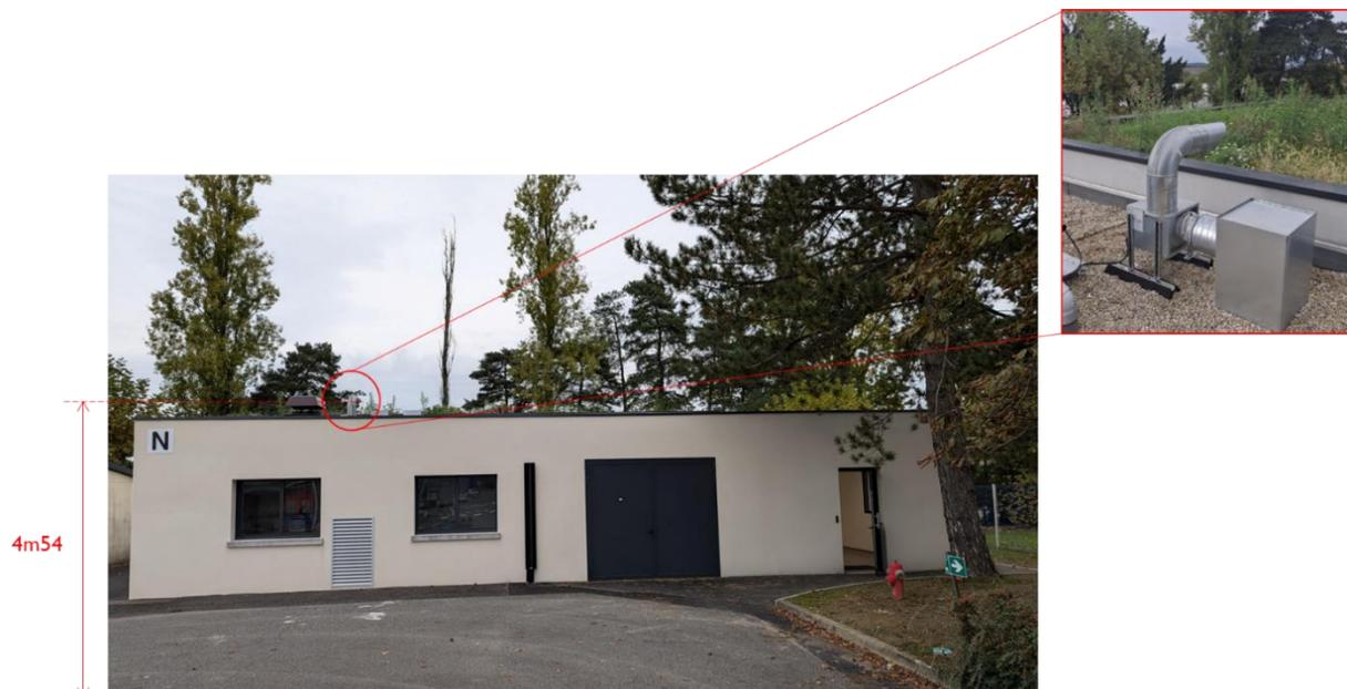
Figure 7 : Positionnement et hauteur de la bouche d'extraction d'air
