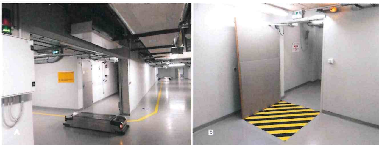
Fig. 9 – Chariot automatique passant sous le portique de détection (à gauche) et local de décroissance (à droite)
